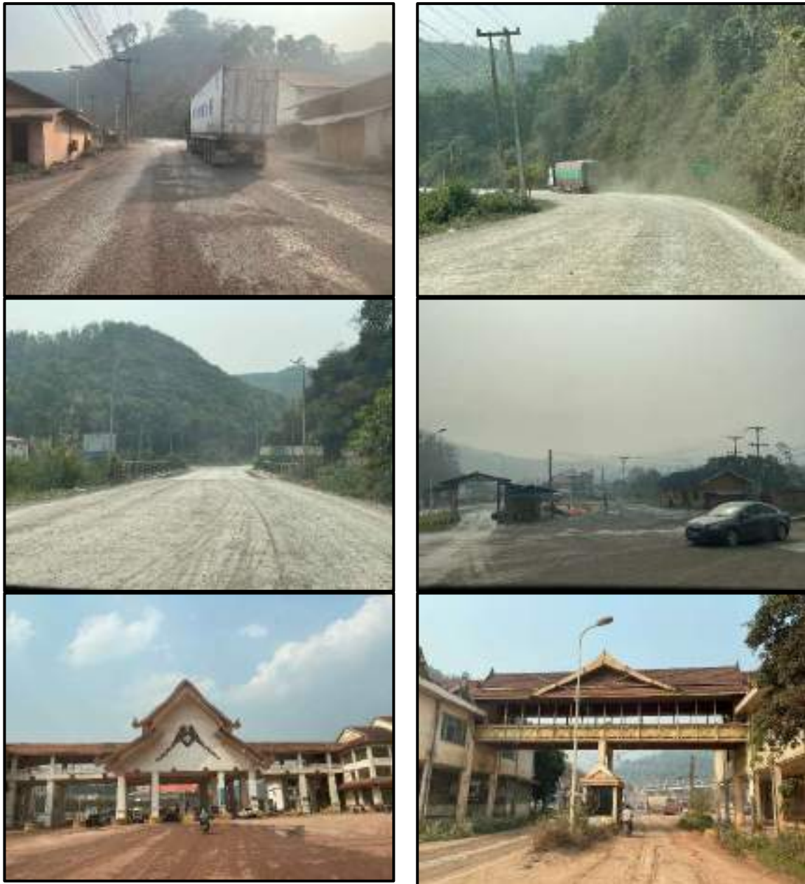
ภาพที่ 4-14 ลักษณะโครงสร้างพื้นฐานทางถนนช่วงห้วยทราย – บ่อเต็น ในเส้นทาง R3A
